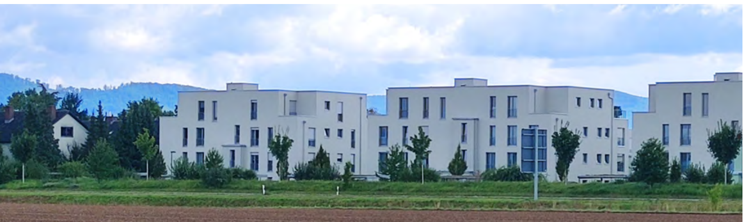
Abb. 20: Ortsrandgestaltung Baugebiet „Mitten im Feld I“ in Heddesheim
